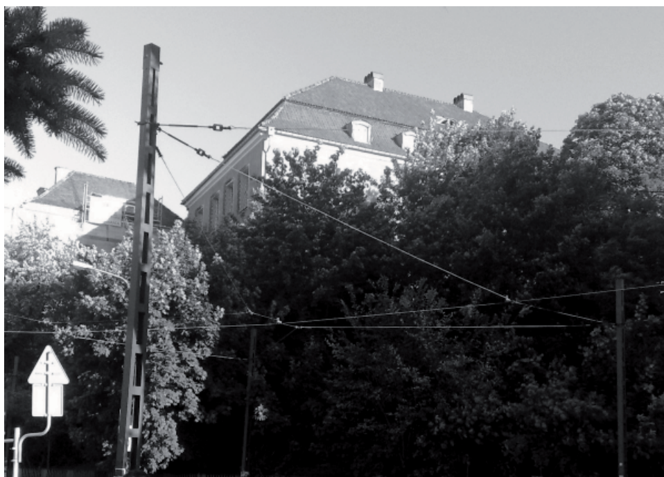
Barak Raczyńskiego ad hoc przez murarza (może niemieckiego?) z cegieł rozbiórkowych machnięty jako budynek wolnostojący.
